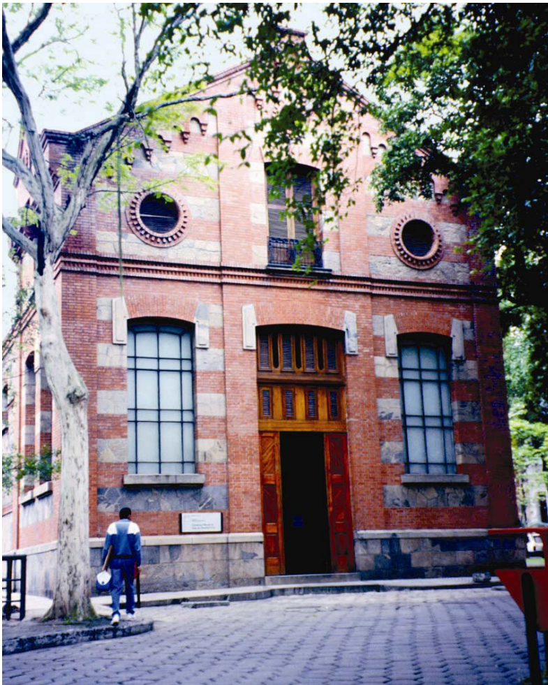
Figura 11: Vista frontal do prédio da antiga cavalaria onde está localizado o Espaço Biodescoberta
