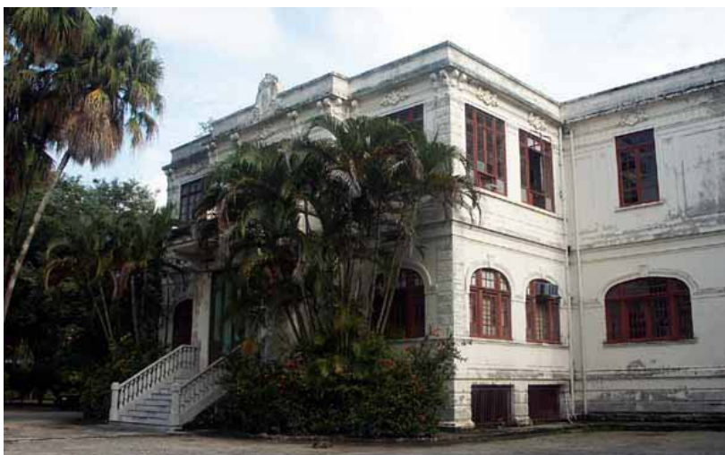
Figura 3: Prédio do Museu Botânico, atualmente fechado
